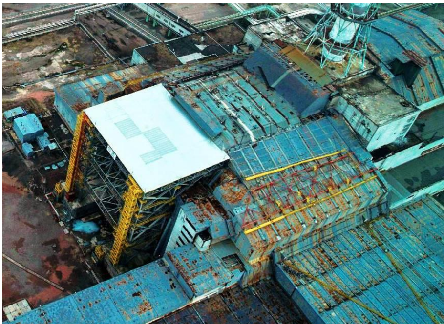
Рисунок 1 – Загальний вигляд об'єкту «Укриття» після виконання стабілізаційних заходів
